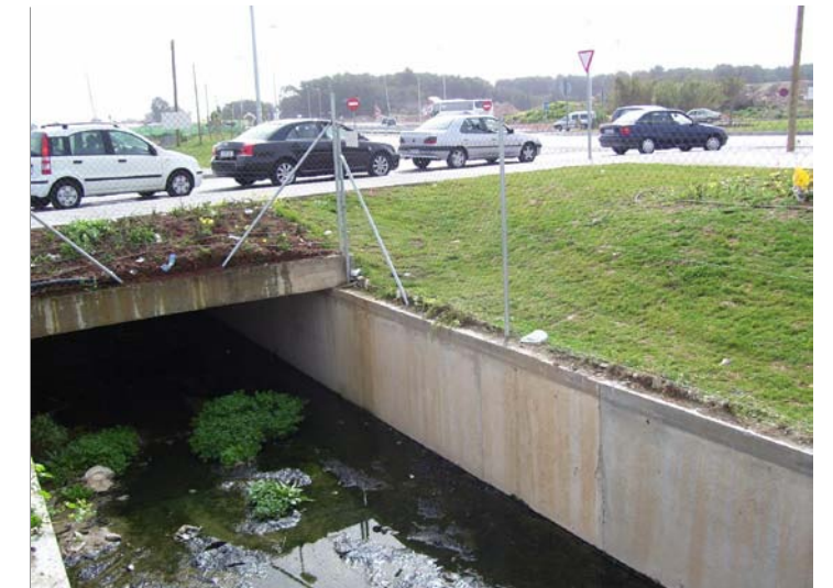
F2 Sección cajón aguas arriba
