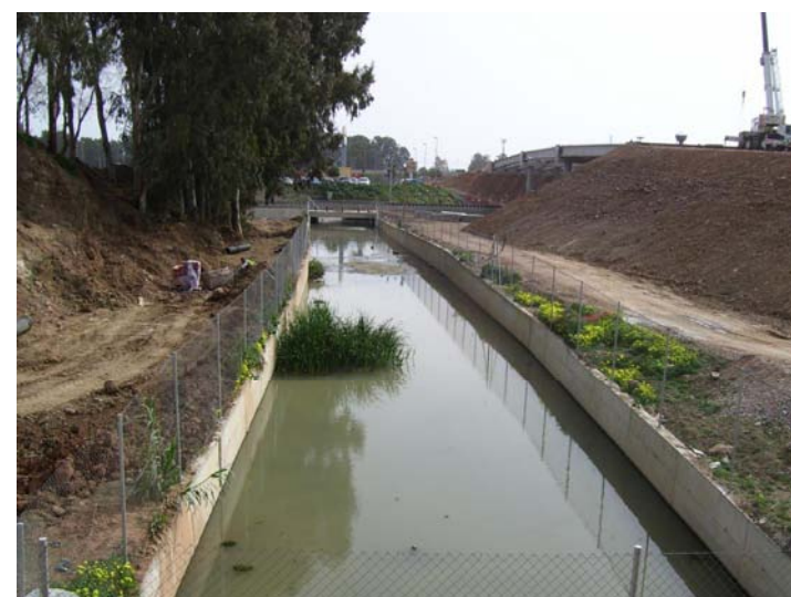
F3 Sección cauce aguas abajo
