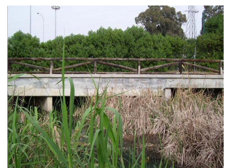
F4 Sección cajón aguas abajo
