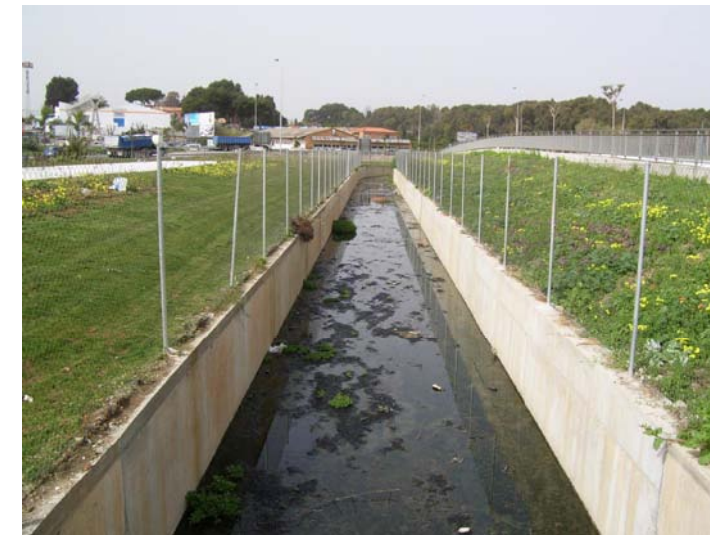
F1 Sección cauce aguas arriba
