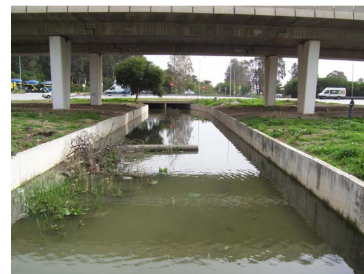
F3 Sección cauce aguas abajo
