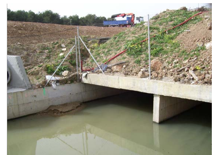
F4 Sección cajón aguas abajo
