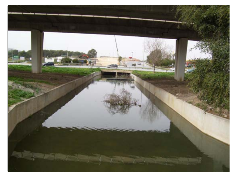
F2 Sección cauce aguas arriba
