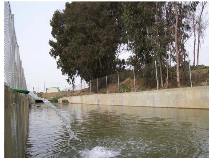
F1 Sección cauce aguas arriba
