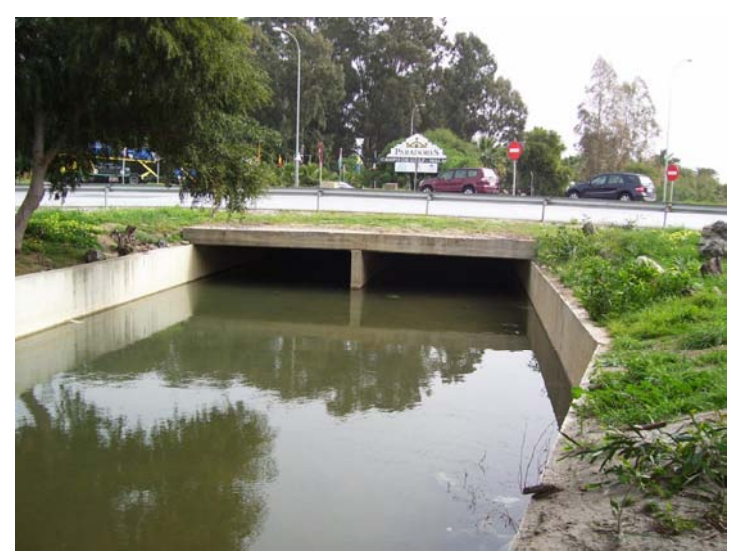
F1 Sección cajón aguas arriba
