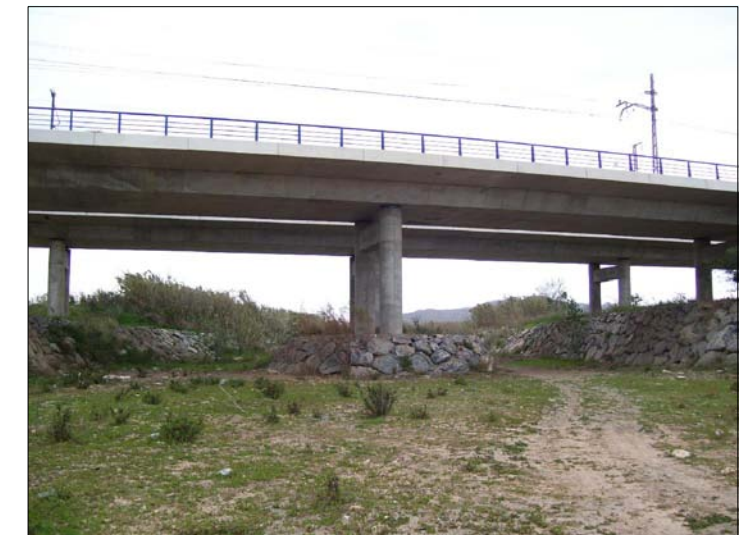
F2 Sección cauce aguas abajo
