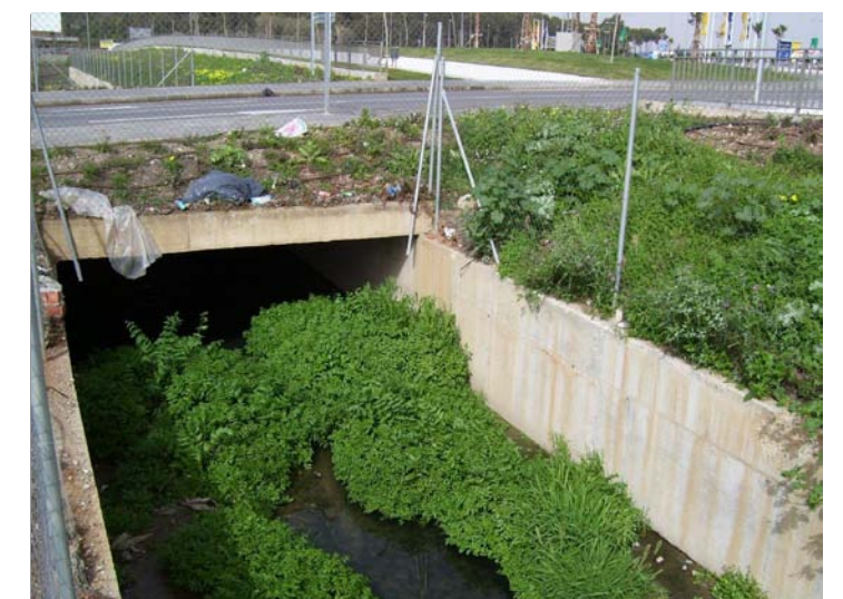
F4 Sección cajón aguas abajo
