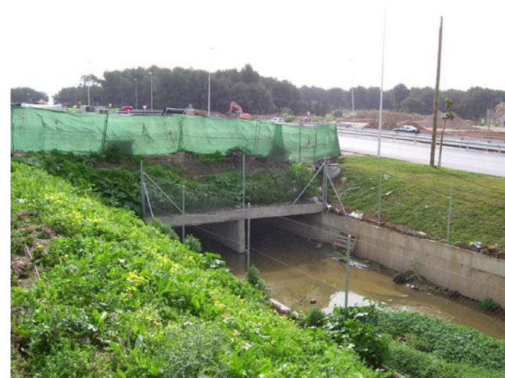
F1 Sección cajón aguas arriba
