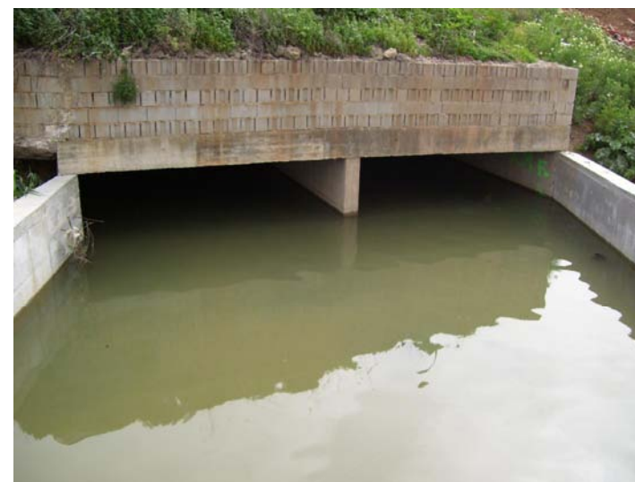
F3 Sección cauce aguas abajo
