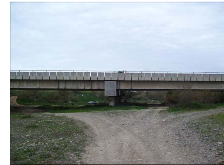
F1 Sección cauce aguas abajo
