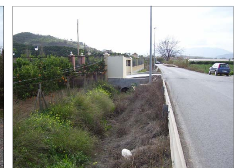
F4 Sección puente aguas arriba
