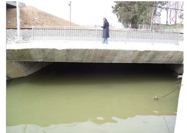
F2 Sección cauce aguas arriba
