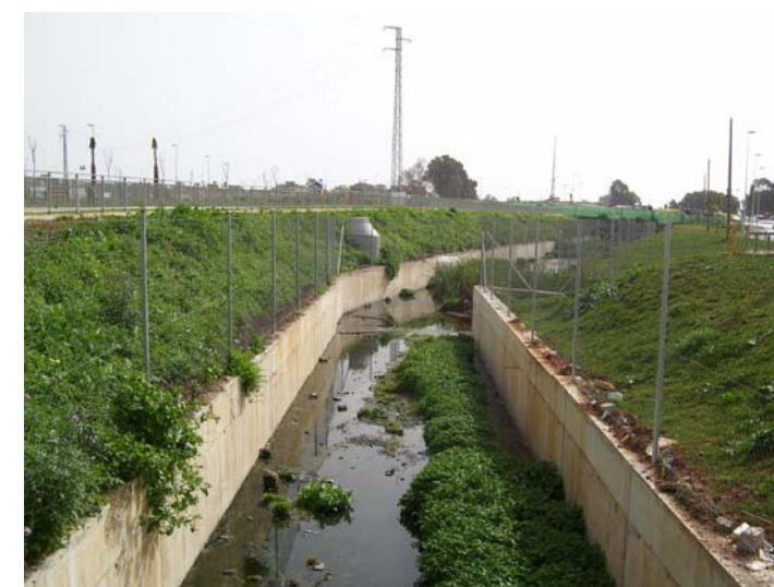
F3 Sección cauce aguas abajo (Estrechamiento por intersección de arroyo)
