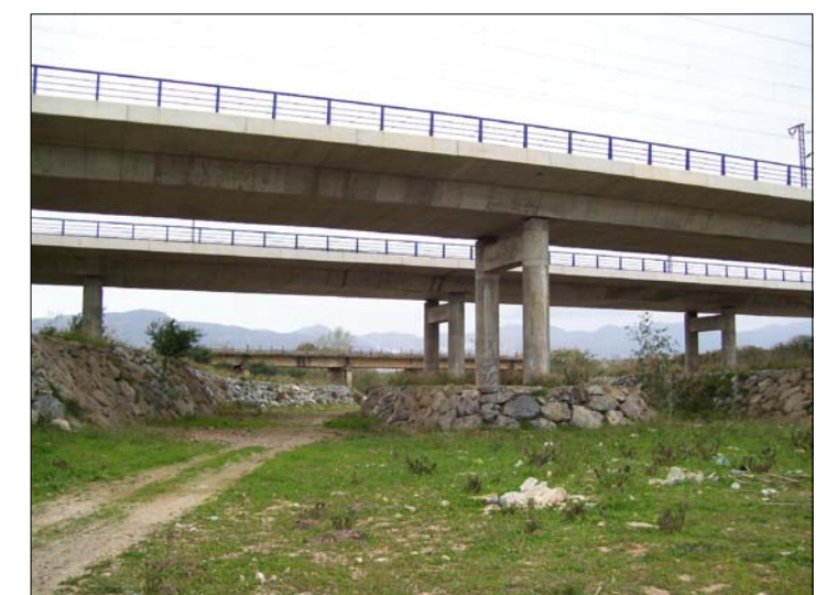
F4 Sección puente aguas arriba
