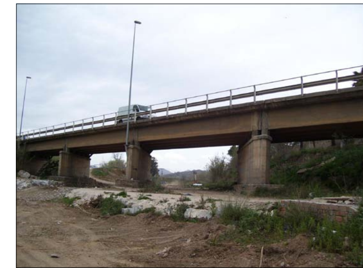
F3 Sección cauce aguas arriba
